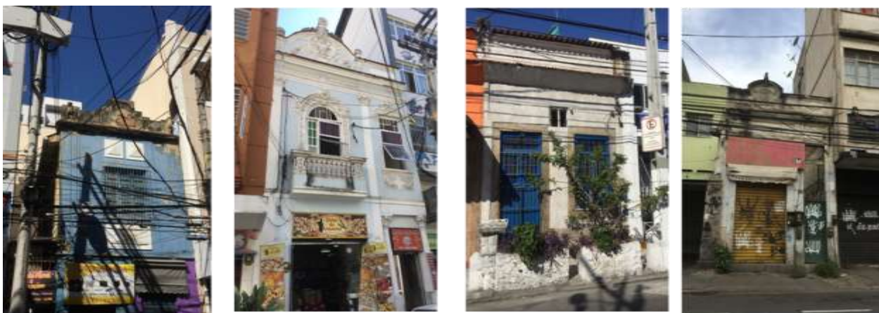
Figura 5: Exemplos de pequenas edificações abandonadas, cidade de Niterói, região Central, destacamos a fiação aérea como impedem e depreciam as fachadas.
