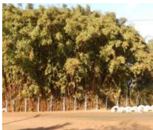
Foto 2. Vista da margem direita da barragem recoberta com plantas de bambu, indicando proteção com alambrado e indicativos de tráfego.
