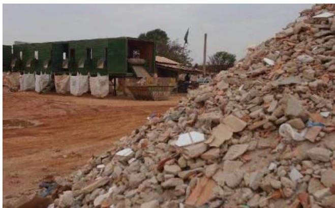
Figura 3: Usina de reciclagem de resíduos da construção civil
