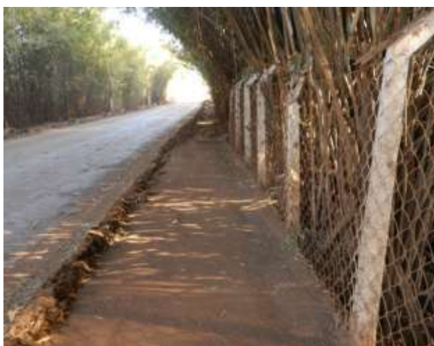
Foto 3. Vista da margem direita da barragem recoberta com plantas de bambu e proteção com alambrado.
