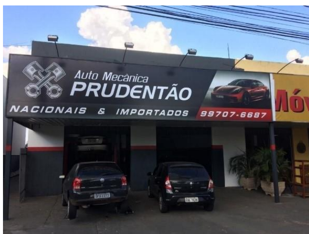
Figura 39: Fachadas em Lona:
