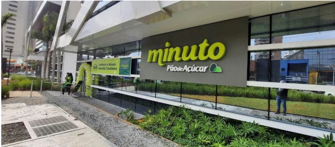
Figura 44: Fachada Minuto Pão de Açúcar - São Paulo SP
