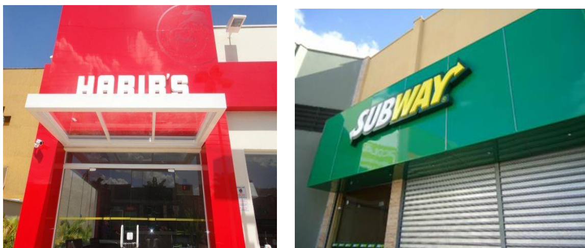
Figura 37: Fachadas em ACM
