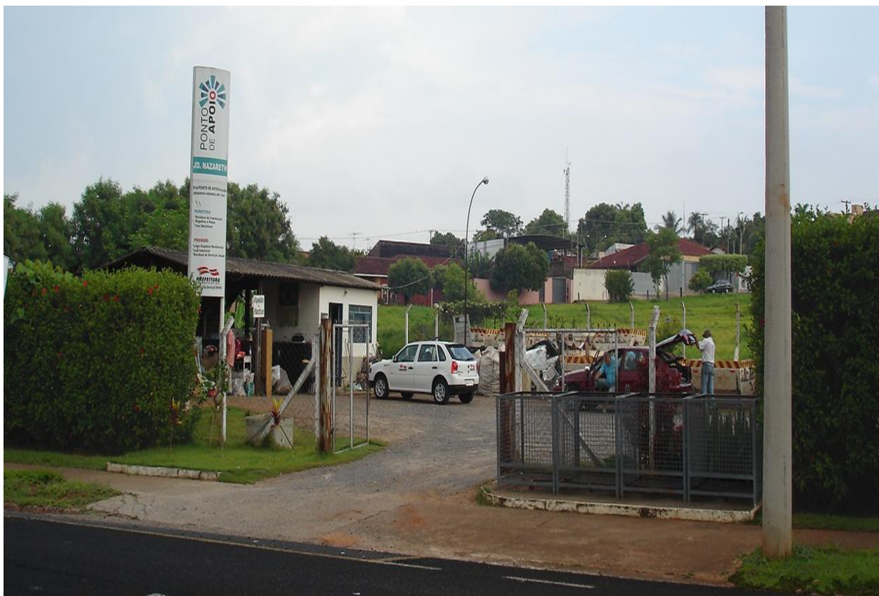
Figura 1: Ponto de Apoio Avenida Salon Varginha
