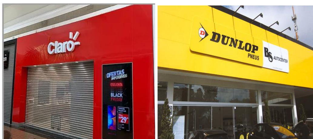
Figura 38: Fachadas em ACM
