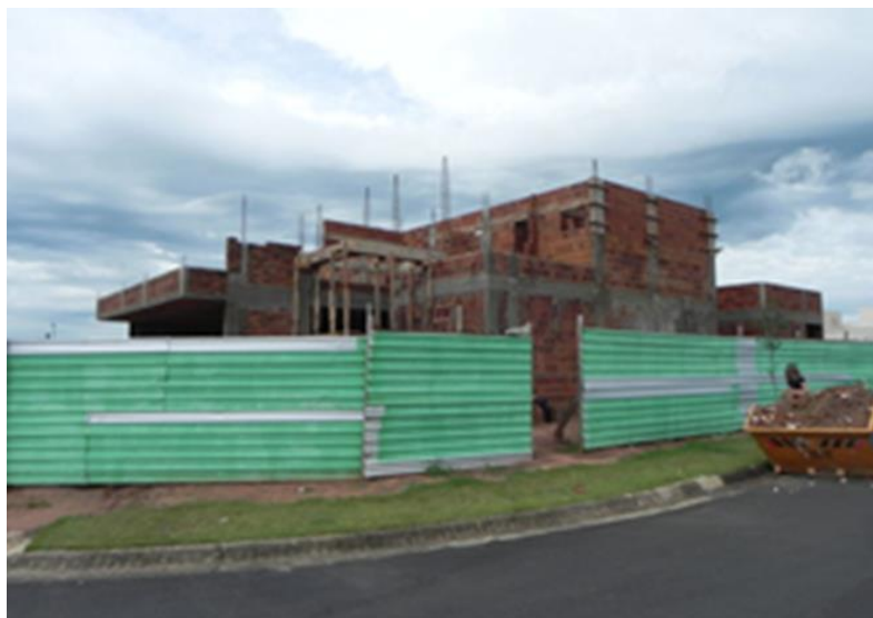
Figura 1. Foto da obra em andamento
