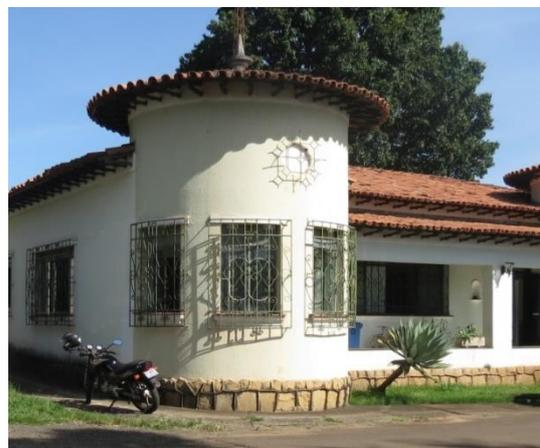
Figura 3: Torre do antigo jardim de inverno. Notar a segmentação das aberturas, a altura da torre, e as saliências nos parapeitos das janelas. Fonte: Acervo próprio.
