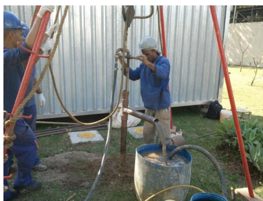
Figura 15: Avanço da sondagem com circulação de água.
