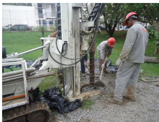
Figura 14: Perfuração de poço de monitoramento com sistema Hollow Stem Auger .
