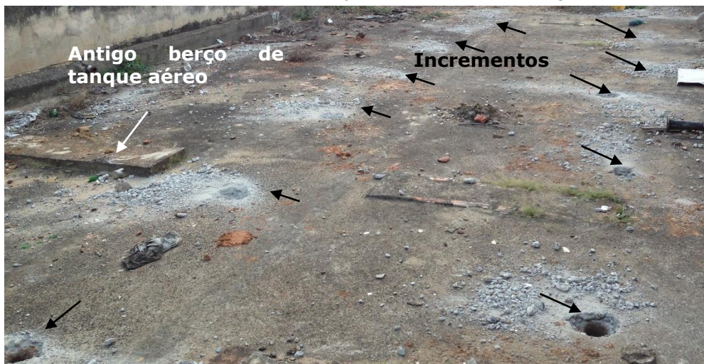
Foto 1 – Parte da área, ilustrando onde foram executadas as sondagens para coleta dos incrementos, além de um dos berços onde tinha-se os tanques aéreos.
