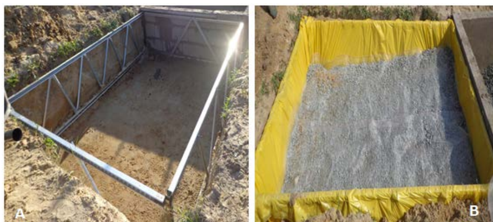
Figura 5: Construção do módulo de fluxo horizontal do WC-Híbrido. Armação de sustentação (A) e lona de impermeabilização com pedra britada (B)
