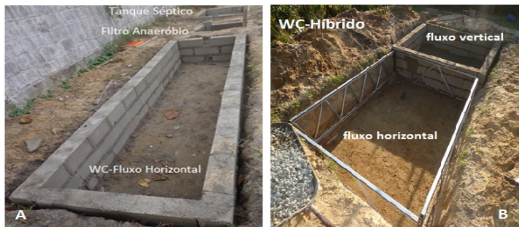
Figura 4: Sistema de drenagem da WC de fluxo horizontal e sistema de alimentação do fluxo vertical da WC-Híbrida
