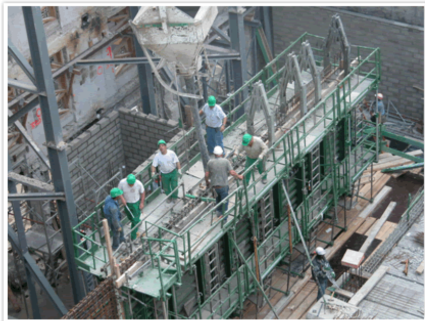
Despejar o concreto, um momento tenso.
