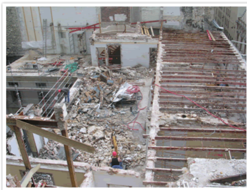
A demolição é a parte mais perigosa de um canteiro de obras.
