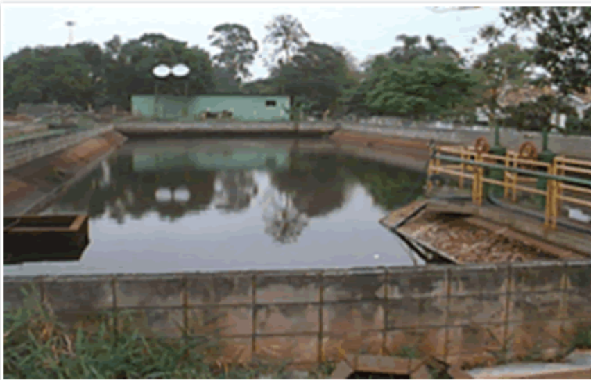
Figura 14 – Ponto de cloração, ajuste de pH e fluoretação, no canal de água tratada
