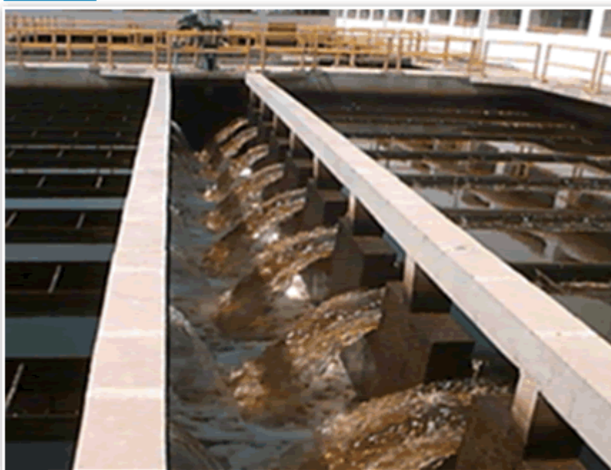
Figura 12 – Retrolavagem dos filtros
