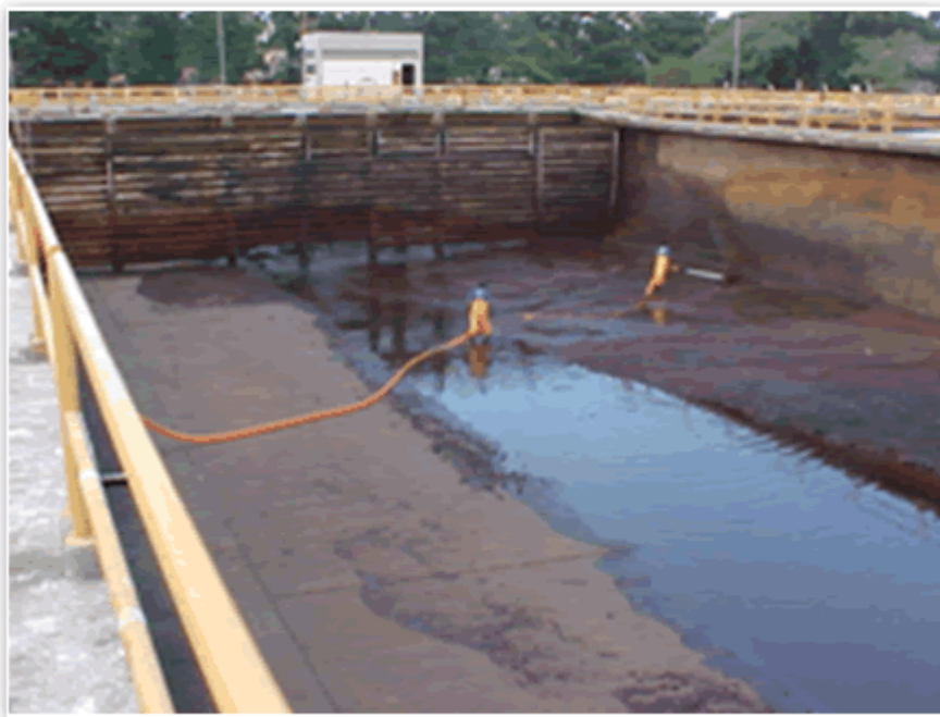
Figura 11 – Lavagem dos decantadores
