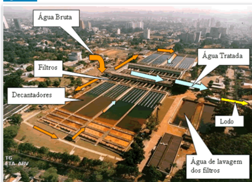
Figura 6 – Vista aérea da ETA-ABV
