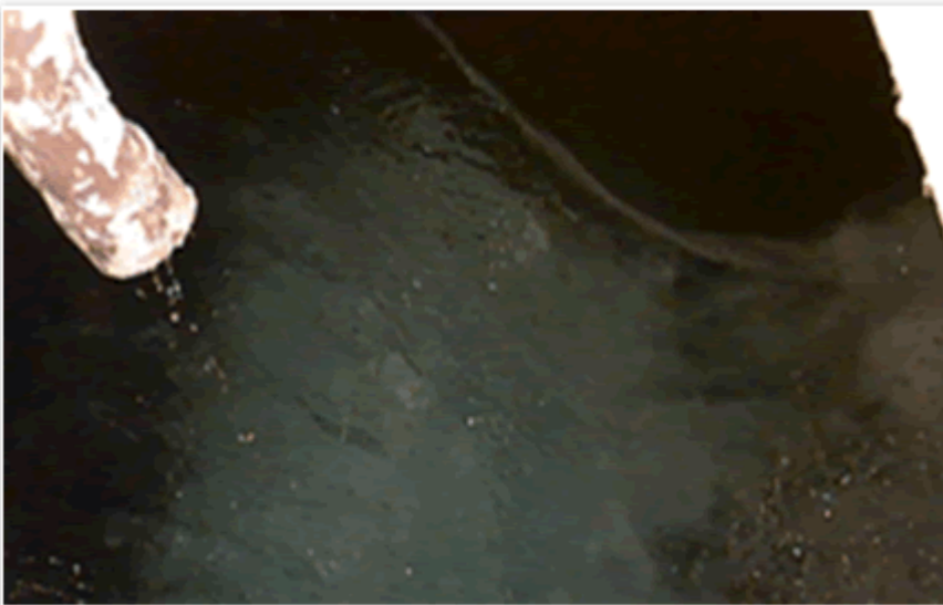
Figura 14 – Ponto de cloração, ajuste de pH e fluoretação, no canal de água tratada
