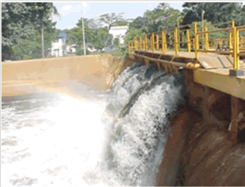
Figura 8 – Vista lateral do dosador de coagulantes
