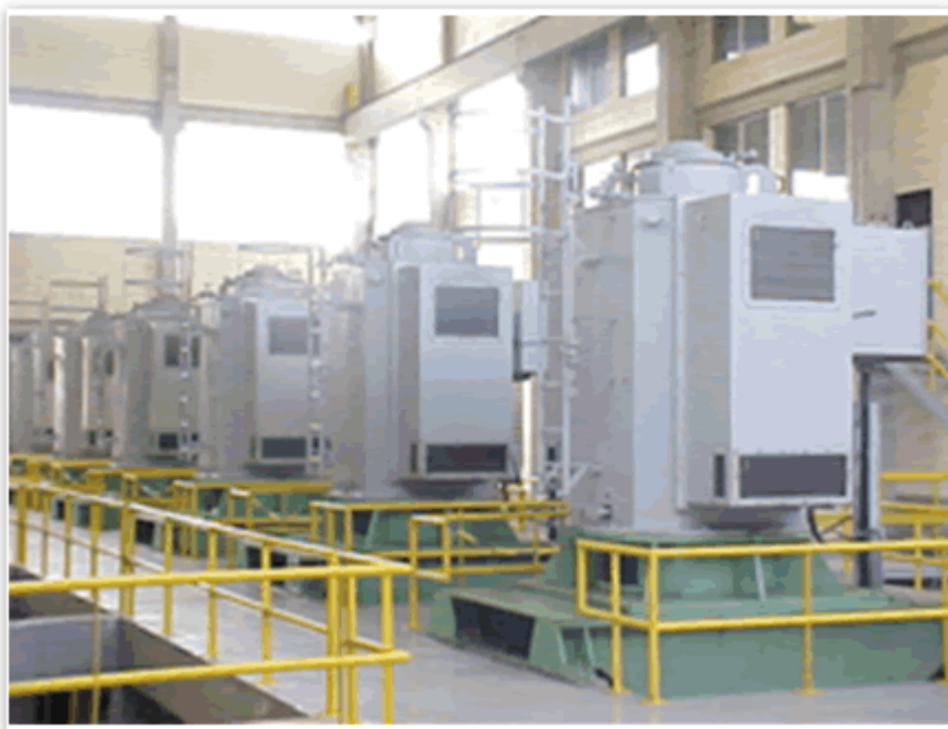
Figura 4 – Estação Elevatória de Água Bruta junto à Represa Guarapiranga
