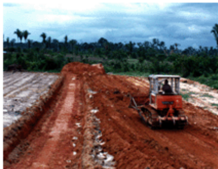
Figura 7 - Aterro tipo trincheira
