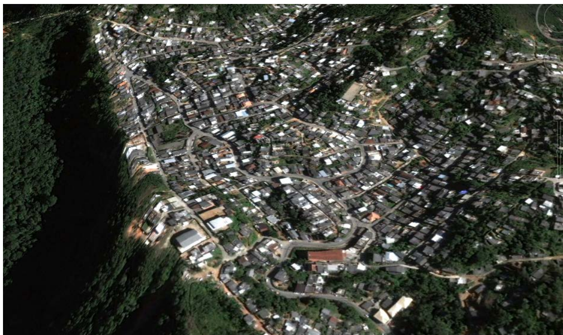
Figura 5. Casas construídas em evidente posição de perigo (Imagem do Google Earth, junho de 2012).
