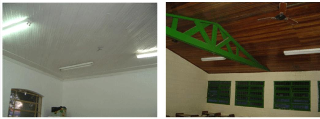
Observou-se em projetos recém-construídos o uso de forro plástico de PVC na cor clara, o que significa tendência à melhor reflexão da luz.
