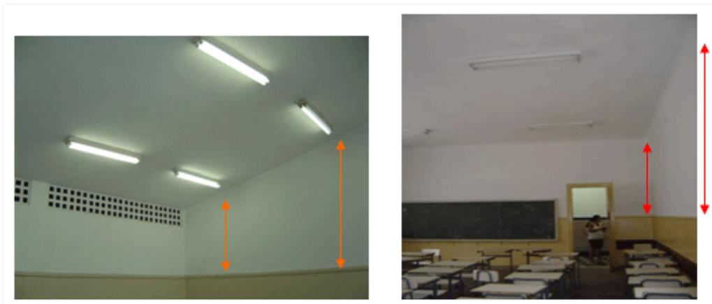
O uso de cores no teto das salas de aula não é uniforme. Assim, observaram-se tetos em concreto aparente, o que significa pior condição de reflexão da luz, com conseqüente condição inferior de iluminamento geral da sala, comparativamente à pintura em branco. Para forros em madeira, observou-se situação similar. As figuras 1, 2, 3 e 4 ilustram essas situações.
