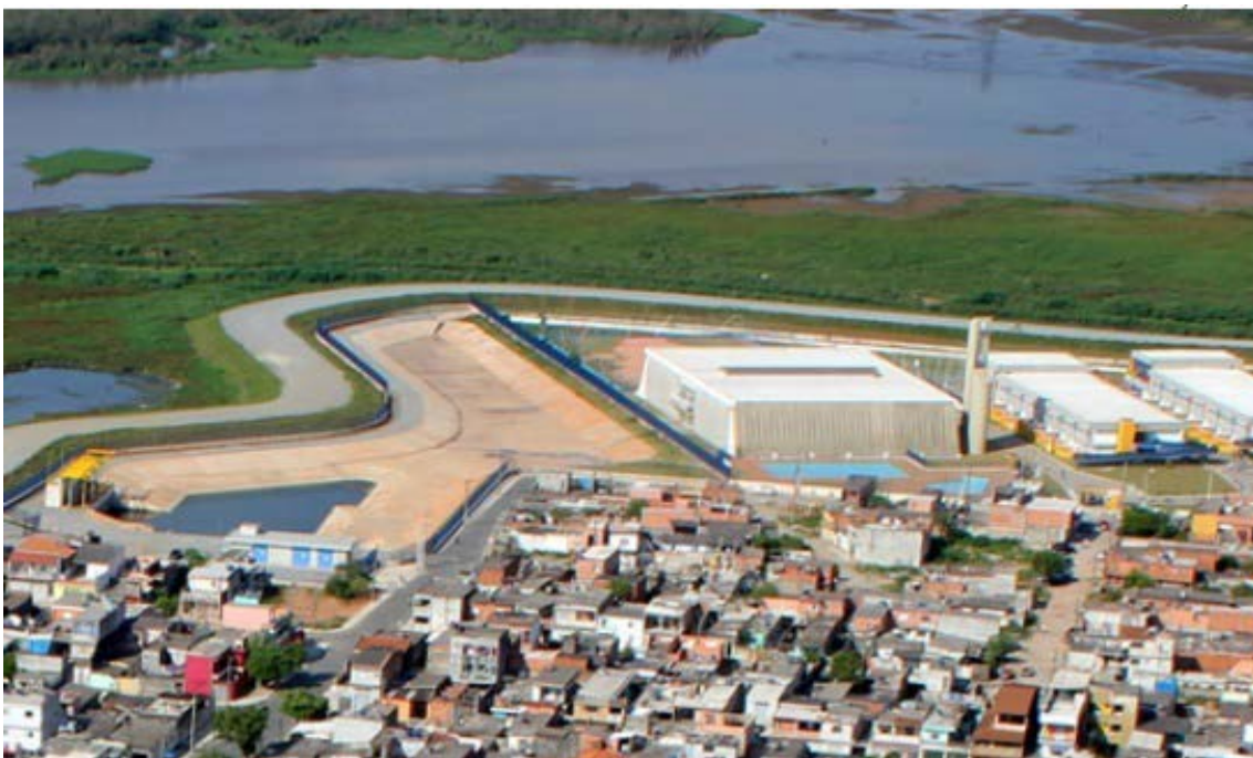
Figura 7b. Visão aproximada do polder construído, com capacidade para 13.000 m 3 e do poço de bombas com 5 bombas com vazão de 800 Lps cada.
