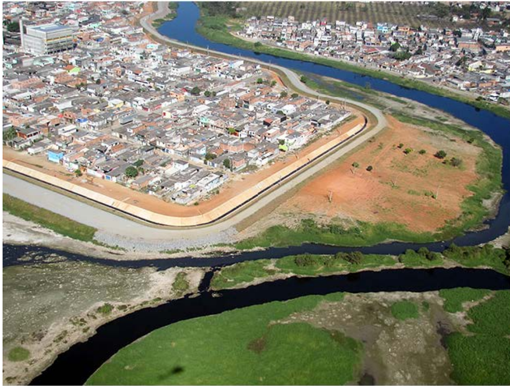
Figura 9. A proteção oferecida pelo dique é parcial, ficando áreas ainda sujeitas a inundações.
